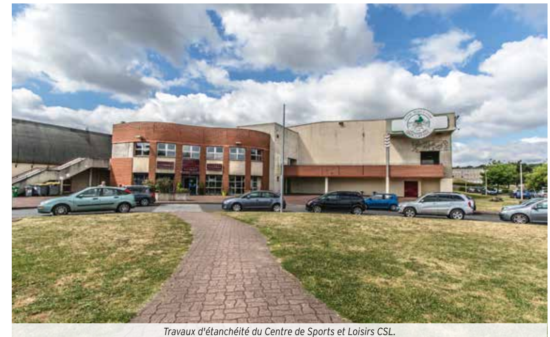
Travaux d'étanchéité du Centre de Sports et Loisirs CSL.
